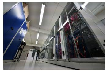
Das mdex-eigene Rechenzentrum in Tangstedt nördlich von Norderstedt umfasst 20 Racks mit aktuell 500-600 virtuellen Maschinen. Bis zur Neuverkabelung hatte der IoT-Service-Provider eine feste TP-Verkabelung mit 24 Ports pro Schrank installiert. Steigende Anforderungen an die Netzwerkinfrastruktur machten die Neuverkabelung erforderlich.
