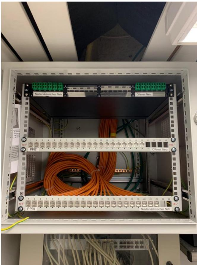
Für die Zukunft gerüstet: Die strukturierte Verkabelung im Cuxhavener Bürogebäude basiert auf dem tBL – tde Basis Link System und berücksichtigt Leistungsreserven für künftige Erweiterungen sowie Migrationspfade zu höheren Übertragungsraten. Quelle: tde – trans data elektronik GmbH
