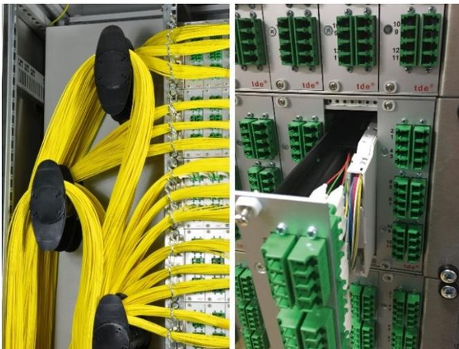
Ordnung im Verteilerschrank: Die Central-Office-Lösung tDF – tde Distribution Frame (ODF) ist benutzerfreundlich und übersichtlich gestaltet und erlaubt Netzwerktechnikern, die Patchkabel sauber zu verlegen. (Bildquelle: tde – trans data elektronik GmbH)
